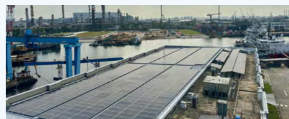
新加坡公司光伏发电
