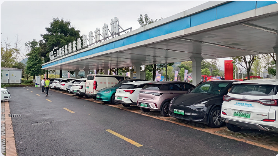
圖 賦能「電動宜賓」建設的充電站
