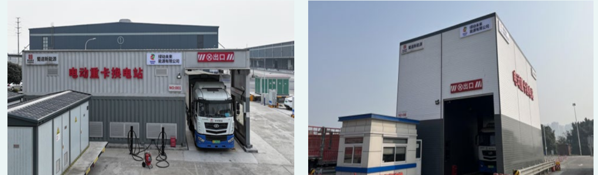
龍泉民生物流園001號電動重卡換電站與資中服務區換電站
