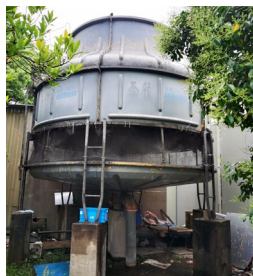
循環冷却水塔系統
