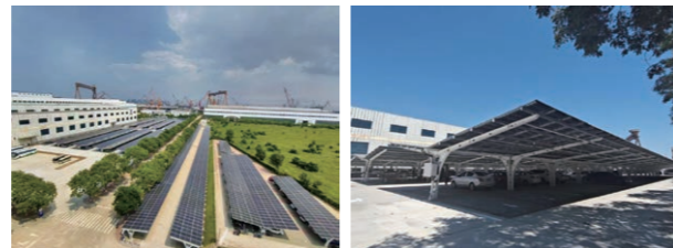
重裝公司佈設光伏板
