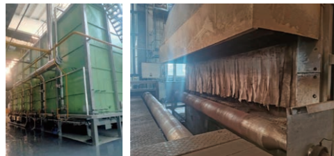
鍋爐公司加熱爐、廠房節能改造
