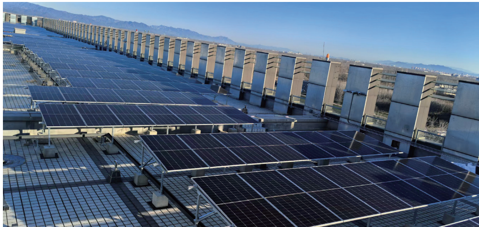
中國航信高科技產業園區室外屋面光伏建設項目
