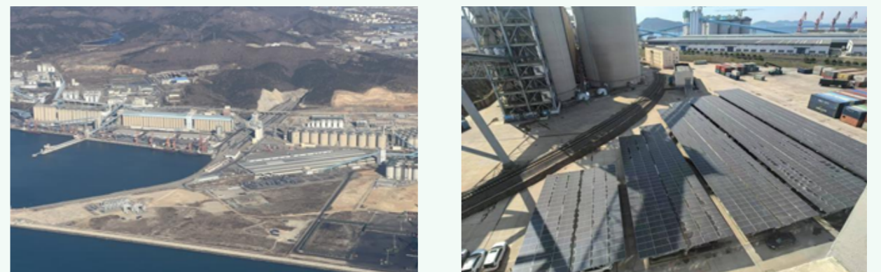
中糧糧谷光伏項目
