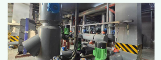
燃氣鍋爐餘熱回收改造
