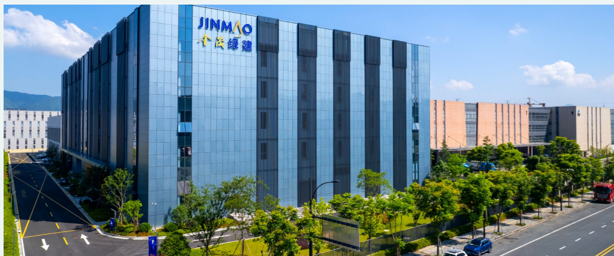
金茂綠建杭州數據中心
