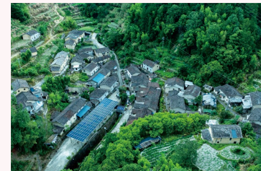
浙江省庆元县黄淤村屋顶光伏援建项目
