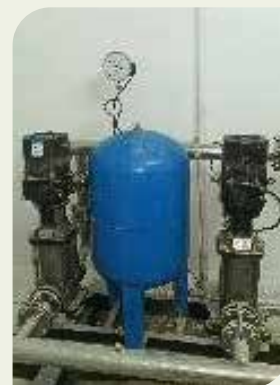
■ 地下滲漏水回收系統
