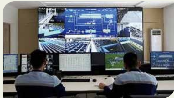
■ 大羅碳中和水廠「智慧水務」集中控制中心
