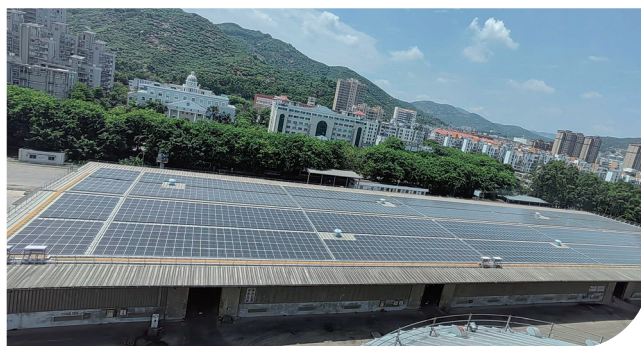
漳州碼頭積極推動分佈式光伏項目落地， 光伏發電自用率達 50% 以上。
