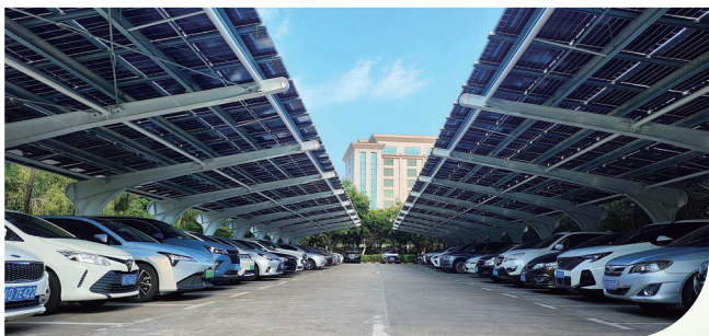
汕頭港採用建築光伏一體化形式建設光伏車棚
