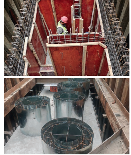
設施施工現場
