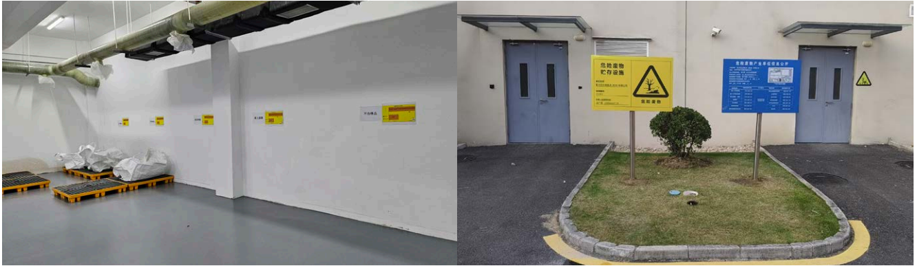
優化後危廢倉現場
