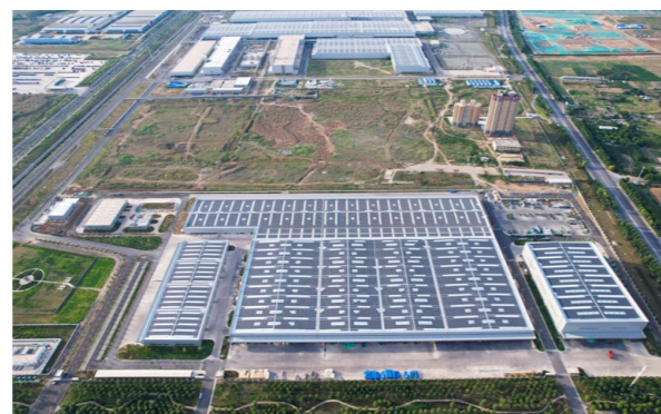
萊蕪工廠分佈式光伏電站
