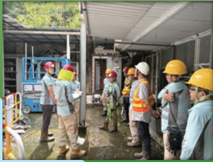
屋頂拆除安全培訓
