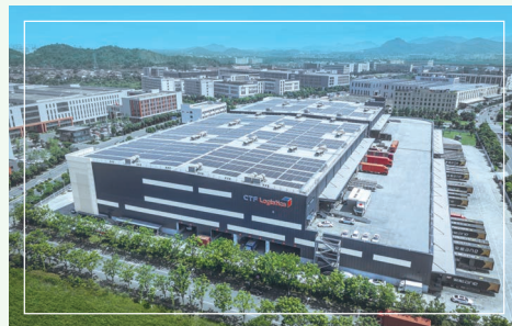
◆ 華東的屋頂太陽能光伏系統
