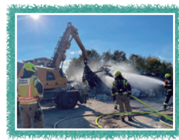
Fire Safety Drill 消防安全演習
